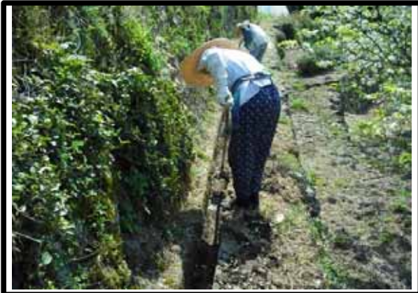
水路の泥上げの状況
