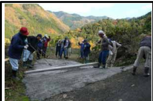
農道の簡易補修の状況
