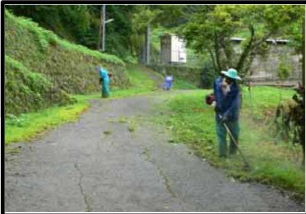
農道の草刈作業状況
