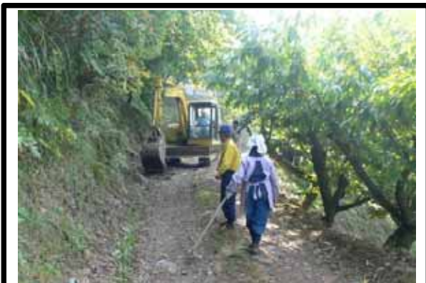
農道の簡易補修の状況
