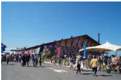
道の駅・萩しーまーと外観
