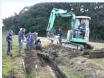
自主施工による水路布設替
