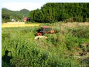
耕作放棄地の復旧作業（作業中）
