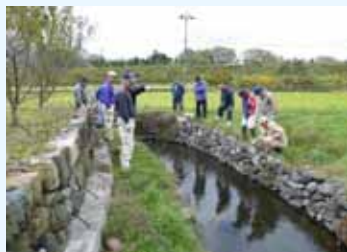
水路施設の点検及び診断
