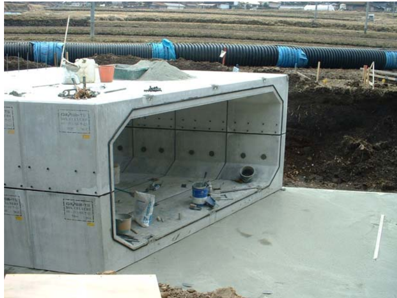
ベベルカルバート（分割型）施工状態
