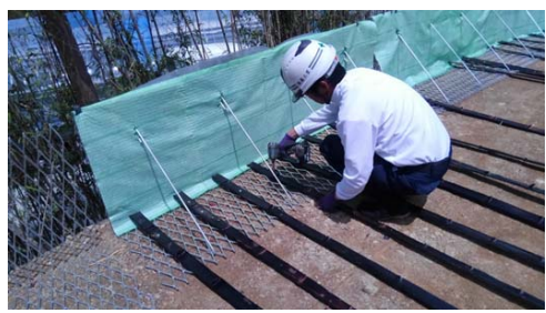
竹補強材取付け状況
