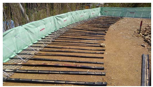
竹補強材の設置状況
