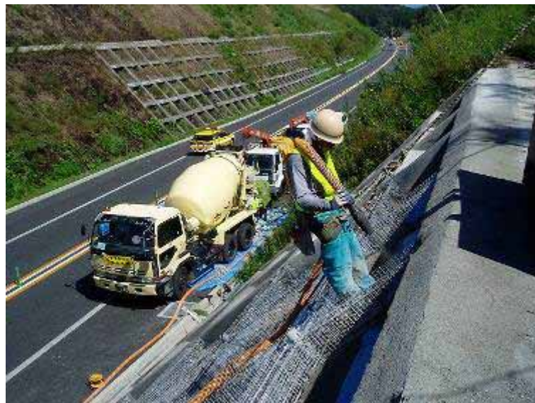
施工状況 (車上プラントによる時間交通規制)
