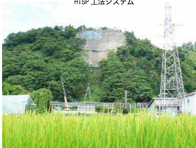
施工状況 (H=130m)
