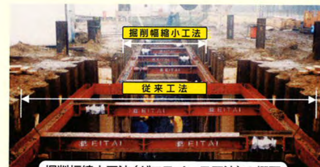
掘削幅縮小工法（ゼロスペース工法）の概要
