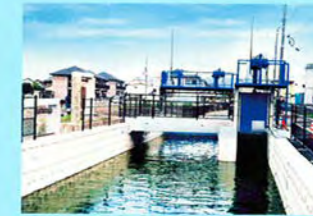
用水路(岡山南部)
