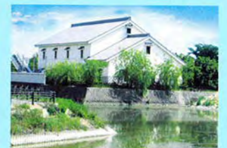
排水機場(山陽東部)
