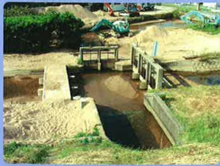
国富幹線水路
