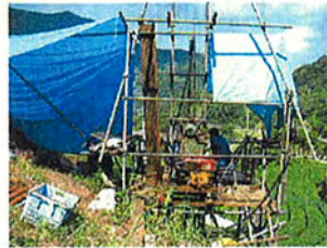
●ボーリングによる地質調査や地下水位の観測
