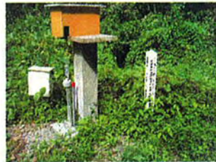
●孔内傾斜計による地下での地すべりの動きの観測
