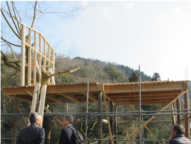
建設中のツリーハウス
