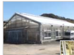
(ガラス温室の緑化室)
