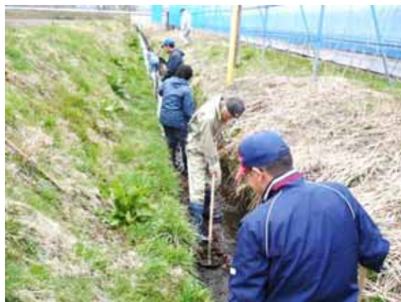
農業用水路の泥上げ作業の様子
