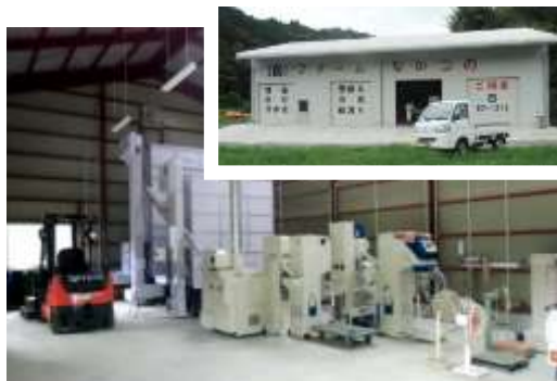
今年から稼働する乾燥調整施設
