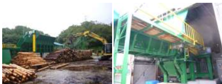
木質チップを生産する施設
