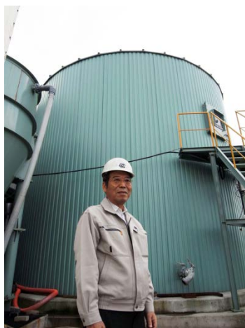
直径8mの生ゴミ処理タンク 県外からの視察も多いそうです
