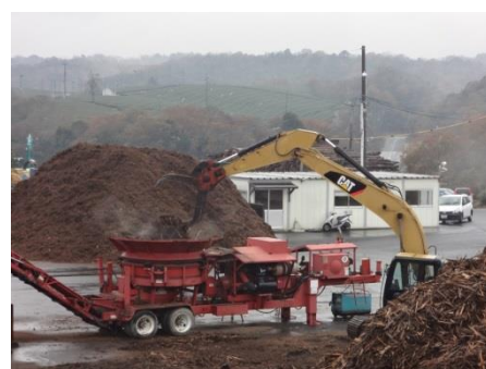
移動式木質系破砕機で木廃材を破砕し運搬
