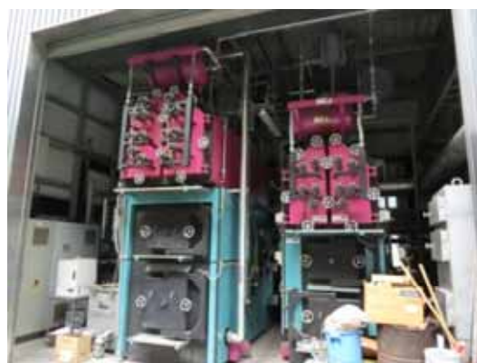
◆木質チップボイラー（オーストリア製） （左：500kW 右：250kW）
