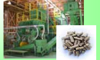
木質ペレット製造施設
