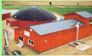
メタン発酵施設
