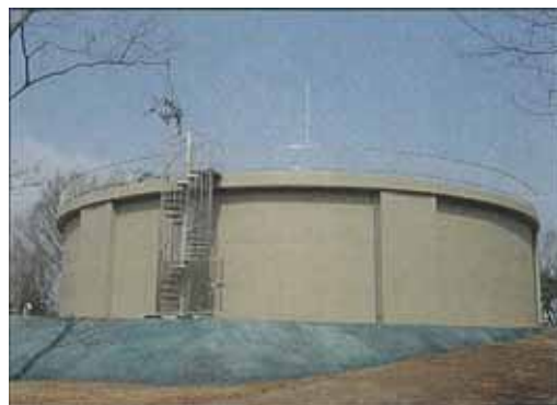
1号配水池(新設)
