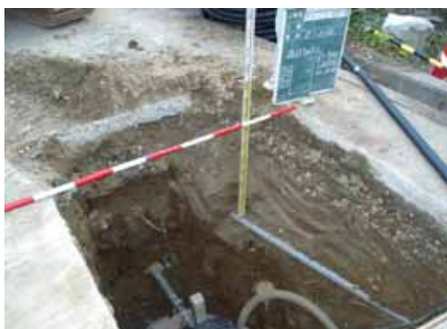
配水管管理設工事の状況
