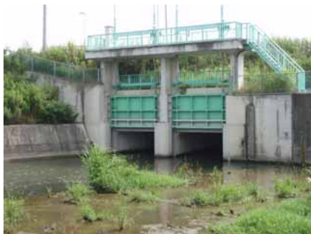
六条暗渠樋門(新設)
