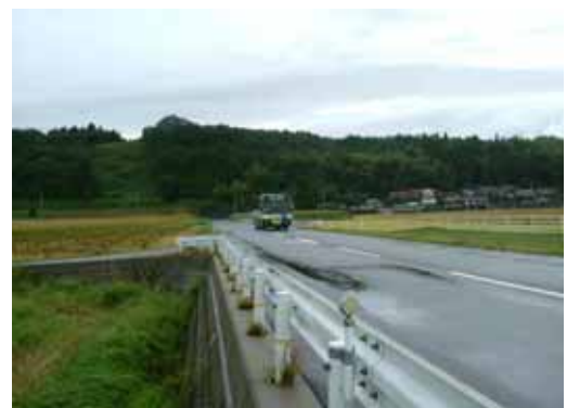
完成し供用している状況
