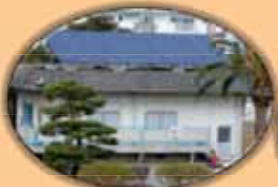
事務所棟太陽光発電システム
