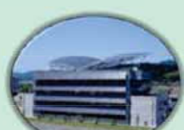
町庁舎の太陽光発電システム
