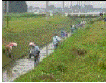
水路の泥上げ
