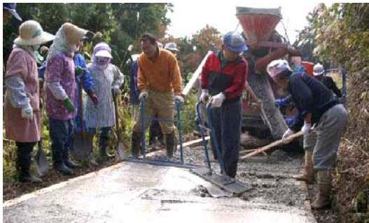
道路を住民がコンクリート舗装
