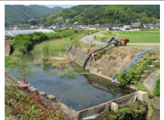
既設排水路を中継池として2台目設置
