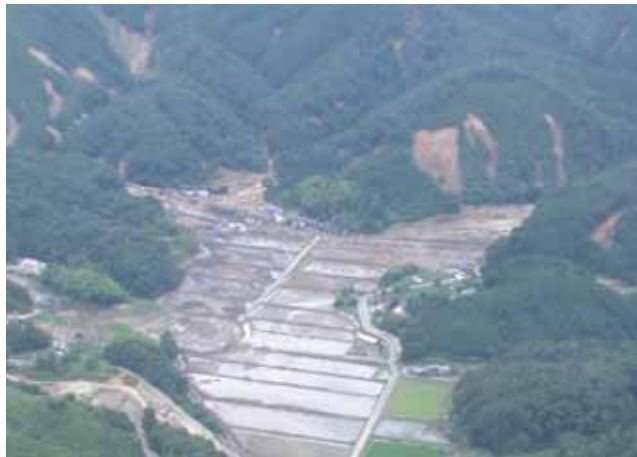
流出土砂により埋没した農地(庄原市西城町)
