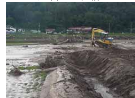
応急対策の実施(排水路の土砂撤去)
