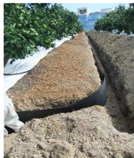
③シート埋設
