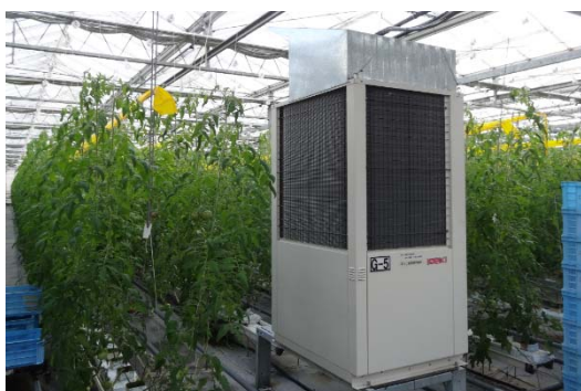
地下水熱源ヒートポンプ（室内機）
