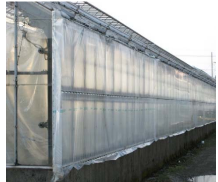
外張被覆をスプリング留め具で固定
