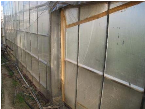
外張被覆の隙間を目張り
