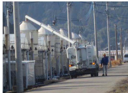
貯蔵タンクへの燃料の投入
