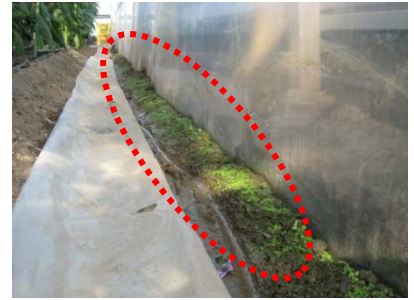
カーテン裾部の固定（土盛り）
