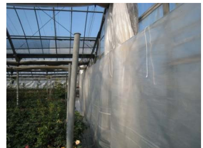
妻面のカーテンの隙間対策②
