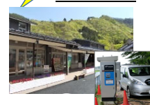
EV車等への給電設備
