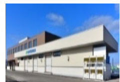
集出荷・貯蔵・加工施設の整備
