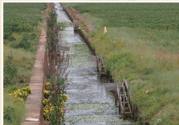
水路に設置された魚道
