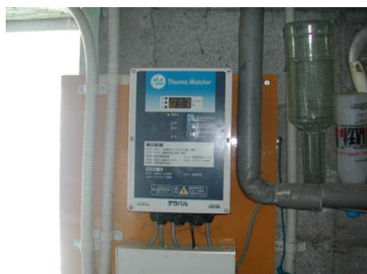
バルククーラーの乳温や乳量を管理する、自記温度計の操作パネル
