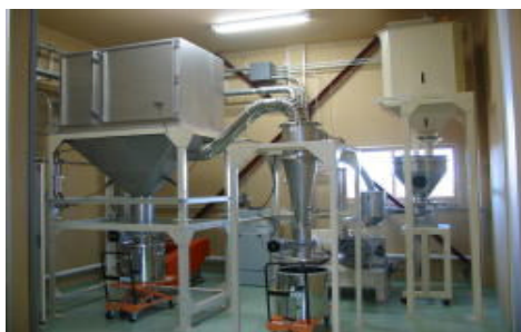
○製粉機械施設
