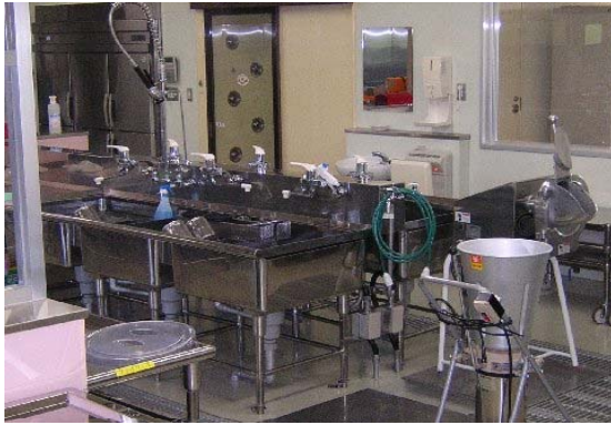
厚真町給食センター調理室
