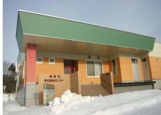
厚真町給食センター外観
