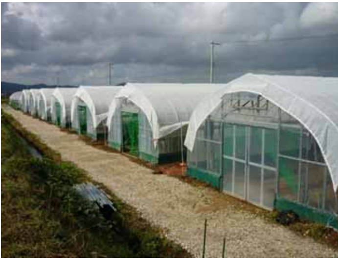
自社で設置したビニールハウス
