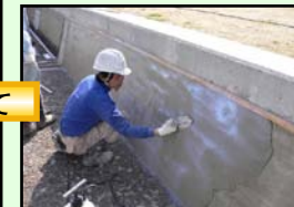
水路の補修・更新
