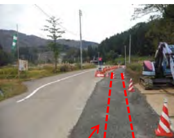
道路下に直径70cmの管を埋設
