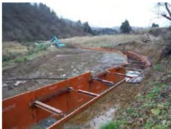
仮廻し水路の全景
