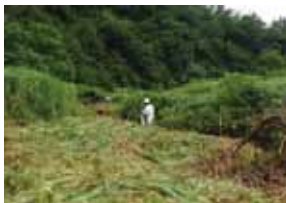
測量作業の様子
