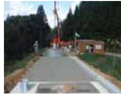
棚入林道(コンクリート路面工)
