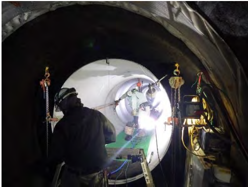
取水トンネル内に導水管(φ1800)を敷設
