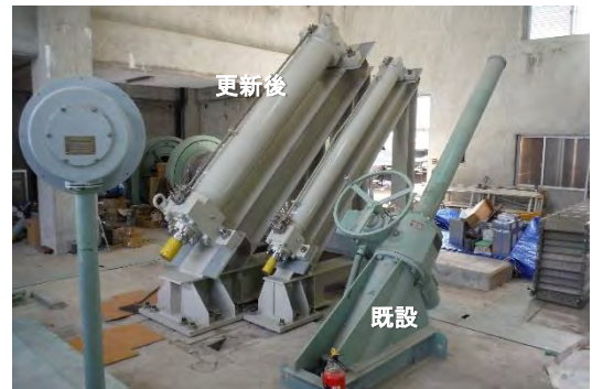
取水ゲート改修(巻き上げ装置の全部更新)
