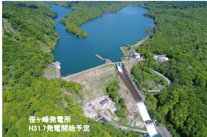
笹ヶ峰ダム 改修工事と併せて小水力発電所を建設中
