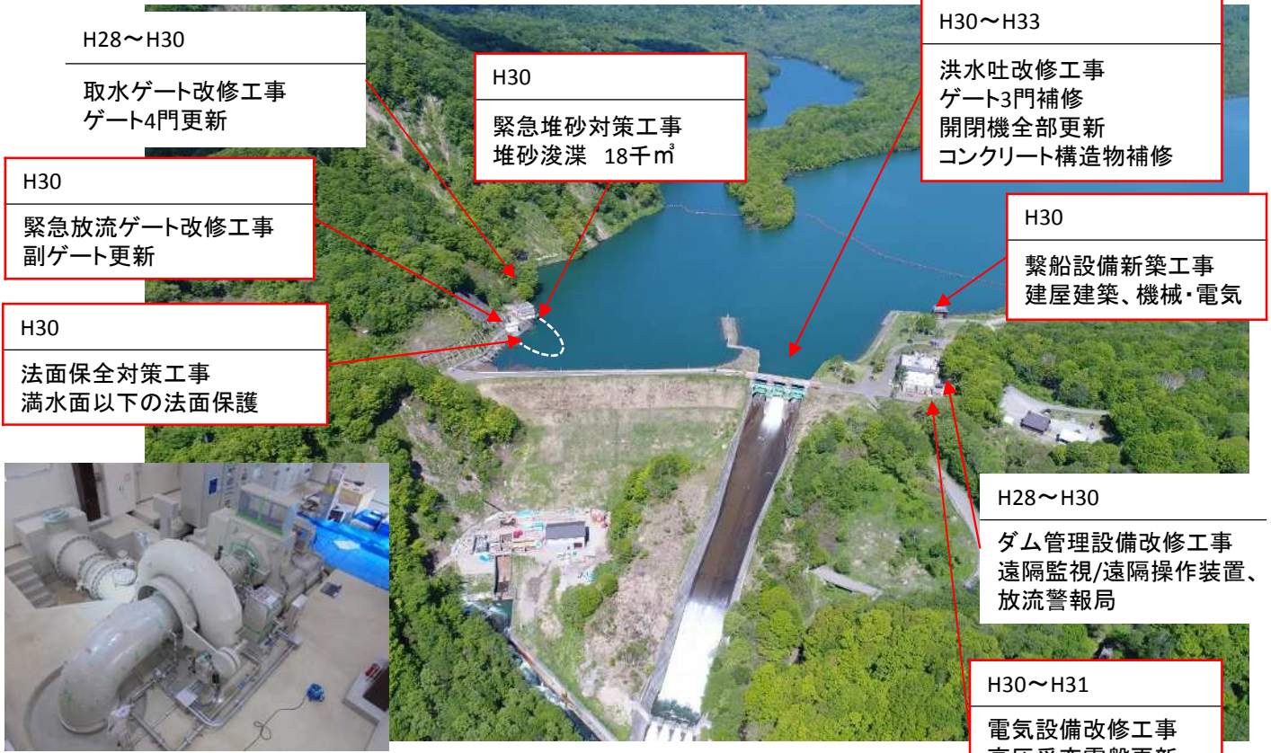
笹ヶ峰ダム小水力発電所 水車・発電機 平成28年度に設置完了 平成31年7月 発電開始予定
