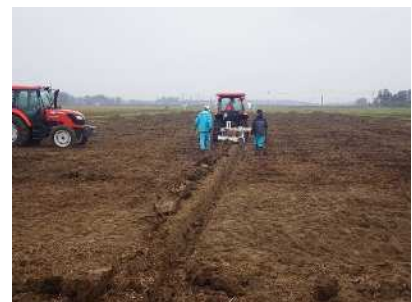
溝掘機による明渠の施工
