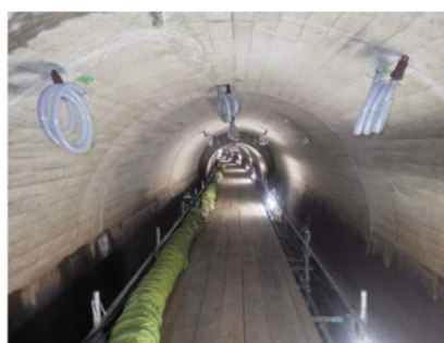
注入ホースを取り付けた様子
