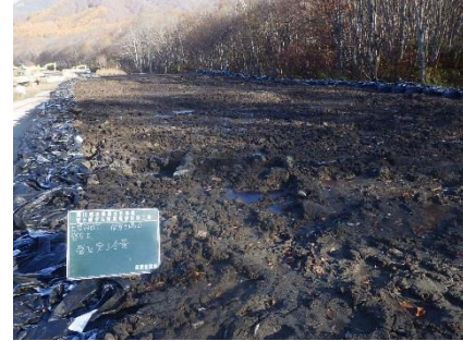
土質改良後、仮置き場に集積された浚渫土
