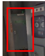
インクライン操作室 分電盤更新
