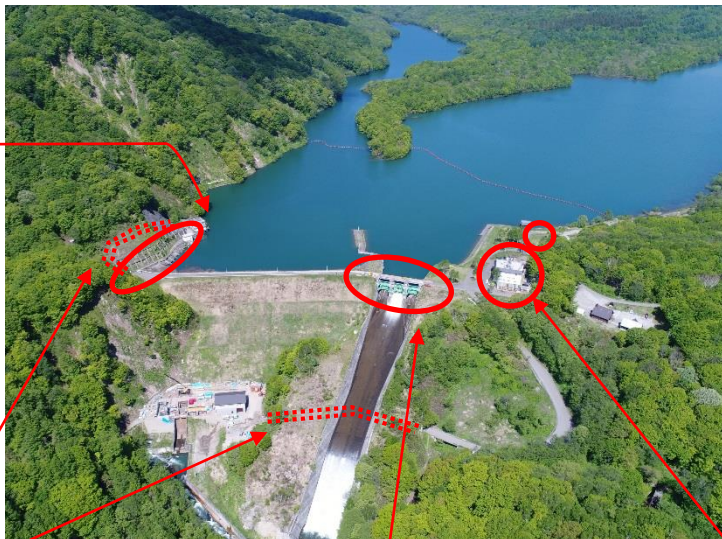
笹ヶ峰ダム周辺の工事实施状況
