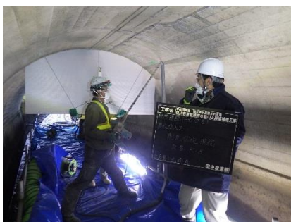
充填のための注入孔を削孔する様子
