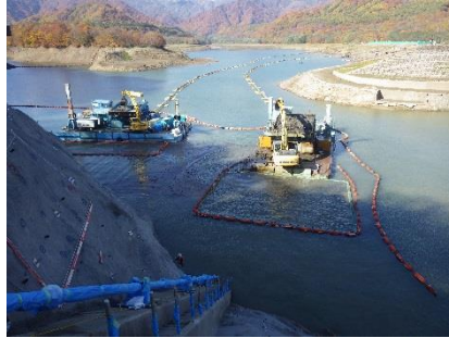
浚渫作業中の状況
