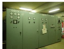
管理棟 受変電設備更新
