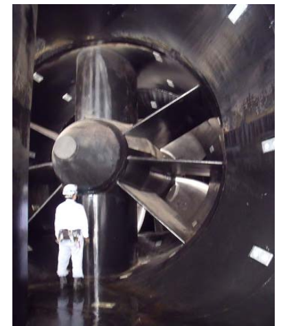
羽根車据付後
