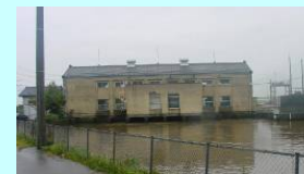
新川右岸排水機場全景
