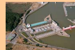
新川河口排水機場全景
