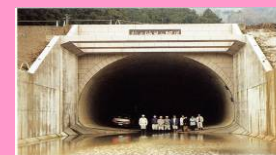
新々樋曾山隧道呑口
