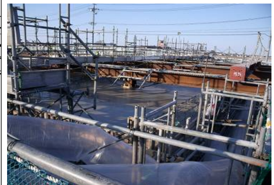
建屋コンクリート打設後
