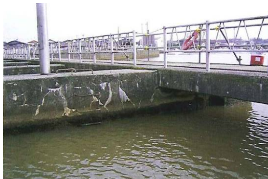
除塵機側壁部劣化状況
