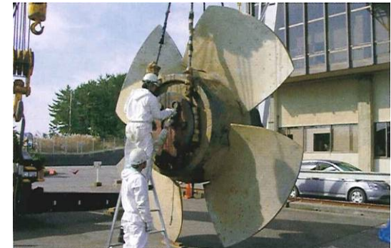
ポンプ羽根車点検状況
