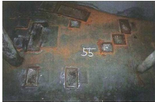
溶接による補修状況
