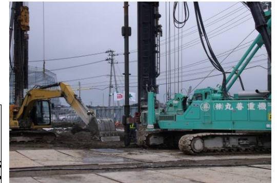
基礎杭施行中
