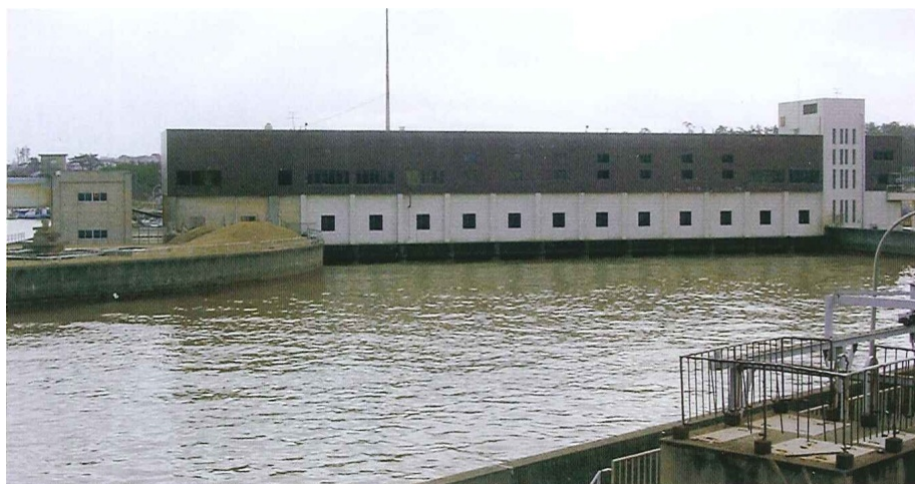
新川河口排水機場
