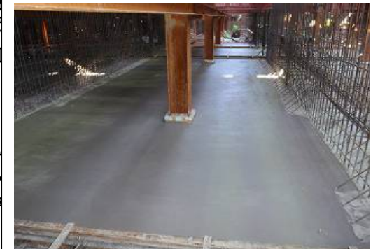
除塵機底板打設
