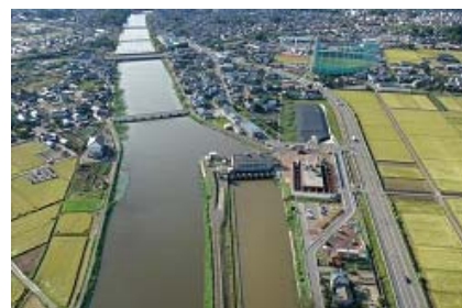
新川右岸排水機場
