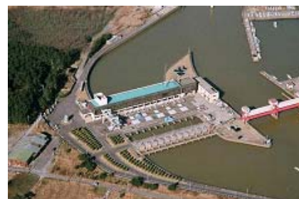
新川河口排水機場
