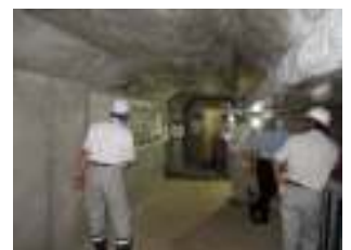
新川河口排水機場にてポンプ改修工事について説明
