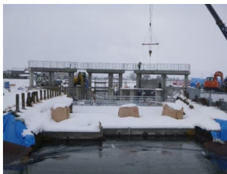
〈三用水分水場改修工事・ゲート製作据付工事〉 分水場本体の改修工事はほぼ完了し、新しく製作したゲート(ステンレス製)の据付を行っています。
