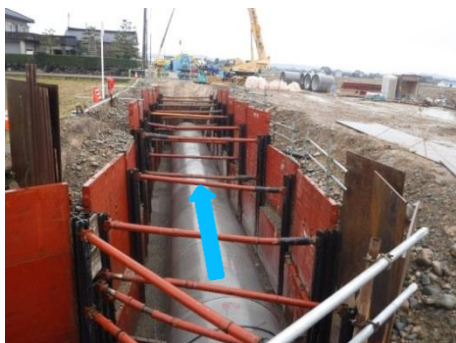
〈荒又排水路(横越工区)その8工事〉 遠心力鉄筋コンクリート管φ2,000mmを、たて込み簡易土留工法により敷設しています。
