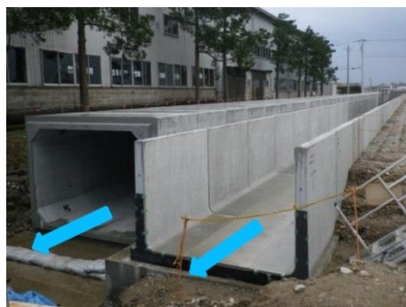
〈庄川放水路(舟戸口工区)その5工事〉 用水路の改修(右:L型水路)と併設排水路の敷設(左:ボックスカルバート)を行っています。
