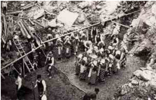
女人夫による搗き固め作業
