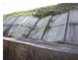
今津川幹線排水路（坂井北部地区）の護岸の陥没
