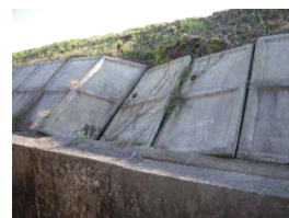
今津川幹線排水路（坂井北部地区）の護岸の陥没
