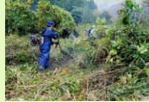
復旧作業の様子
